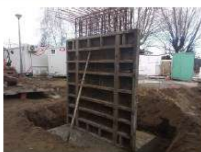
Foto 04 - Acesso coberto: cofragem parede maciça
