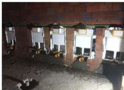
Foto 03 - Instalações sanitárias II: estrutura sanita suspensa
